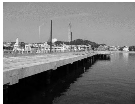
<그림 4.22> 해안에 시공된 강관말뚝 기초 및 완성된 제방도로
