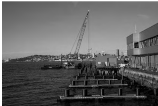
<그림 4.35> 강관말뚝 시공전경
