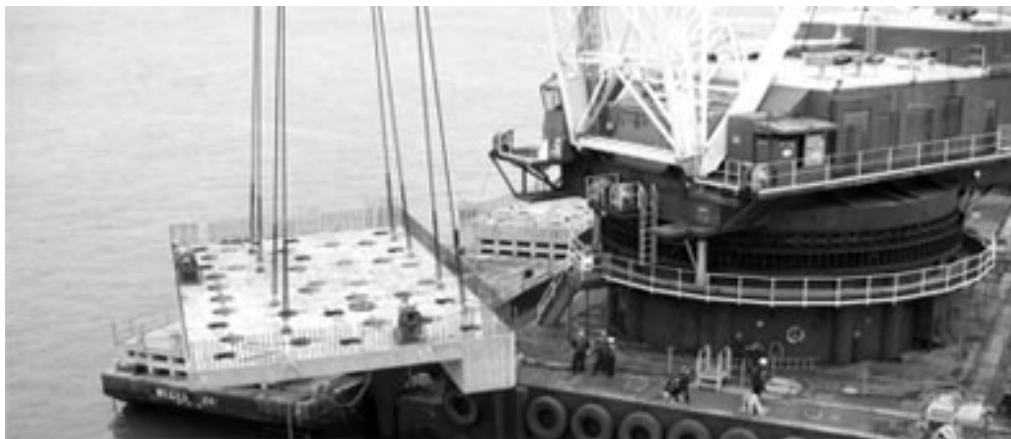
<그림 4.29> 계류돌핀 상부구조 시공전경
