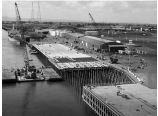
<그림 4.32> 항타 강관말뚝 시공전경
