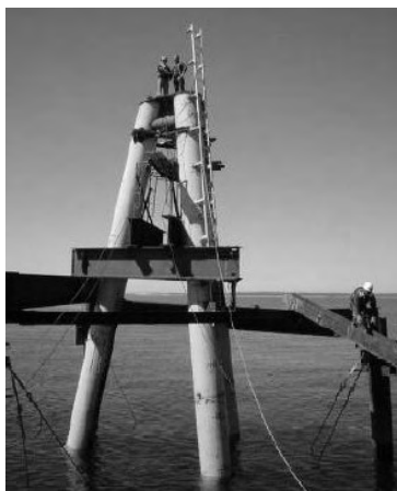
<그림 4.24> Steel pipe pile tripod structure
