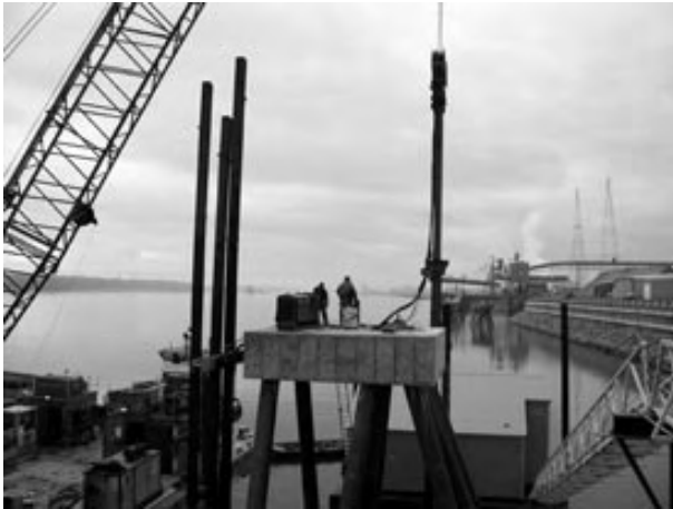
<그림 4.32> 항타 강관말뚝 시공전경
