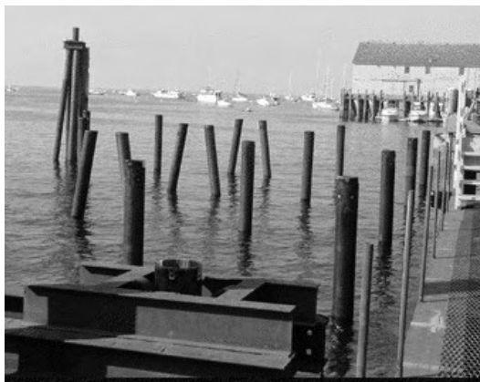
<그림 4.22> 해안에 시공된 강관말뚝 기초 및 완성된 제방도로
