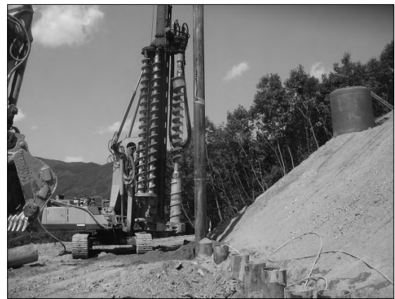
<그림 5.1> 억지말뚝 시공전경
