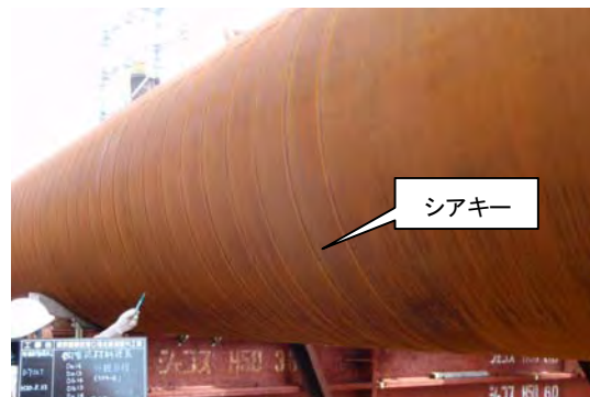
写真-7.1 シアキー（鋼管杭外面）
