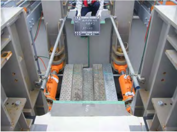
写真-8.3 遊間調整用ジャッキ設置状況
