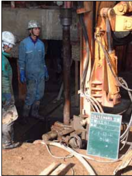
① 鋼管の引抜き
