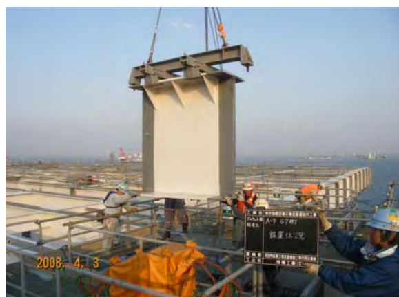
写真-8.2 結合材設置状況
