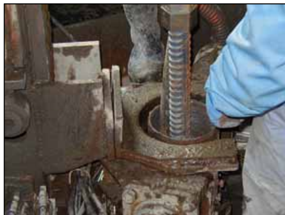
- 1 補強鉄筋の挿入
