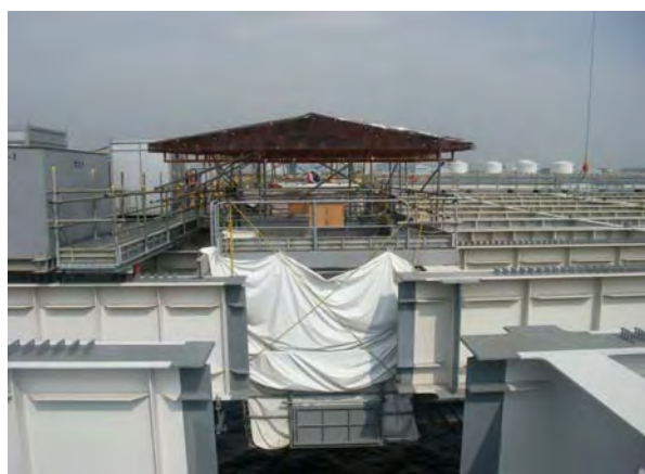
写真-8.1 雨対策用屋根設置状況
