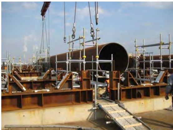
写真-3.4 素管の溶接架台上設置
