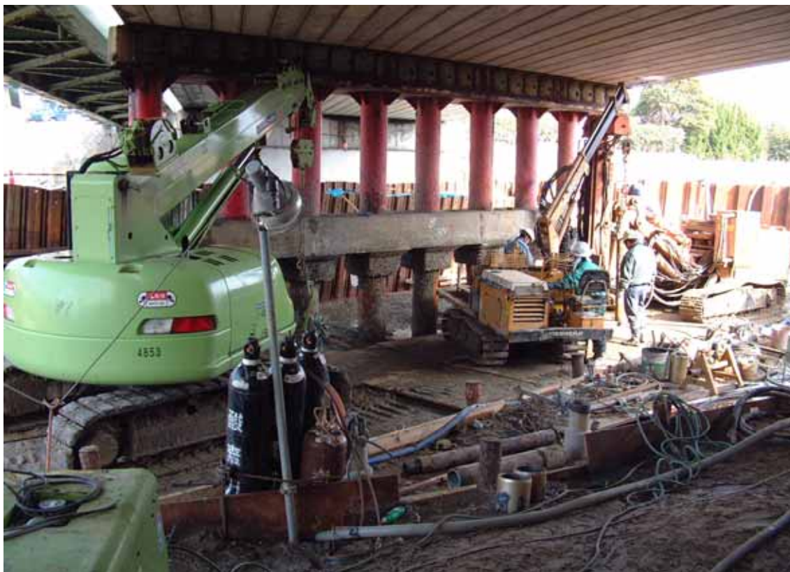
写真 - 4 高耐力パイルの施工現場
