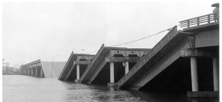
写真 - 1 新潟地震による昭和大橋の落橋
