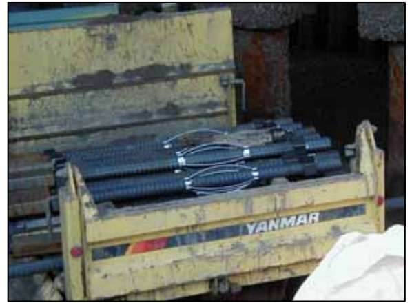
補強鉄筋(D51)
