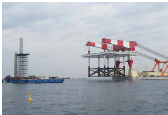
写真-5.4 ジャケット運搬台船係留解除
