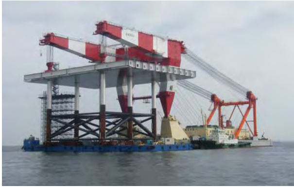
写真-6.4 ジャケット玉掛け・水切り
