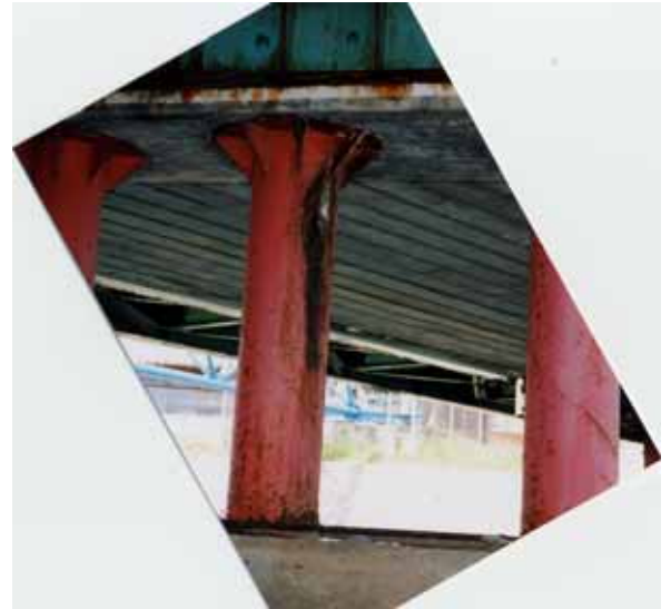
写真 - 2 補強前の橋脚柱
