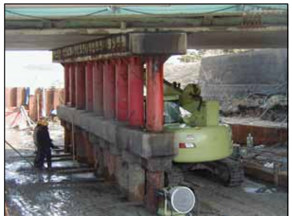
フーチングの打設完了状態
