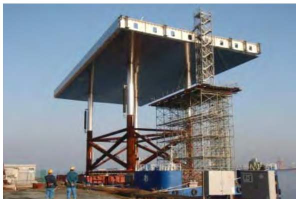
写真-5.1 ジャケット工場浜出し
