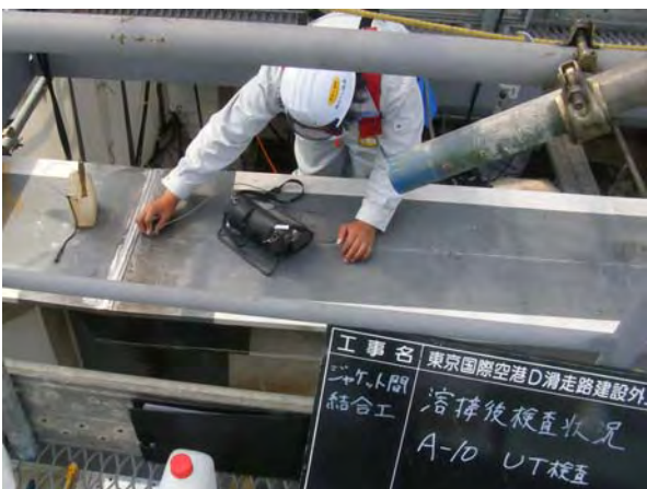
写真-8.5 溶接部非破壊検査
