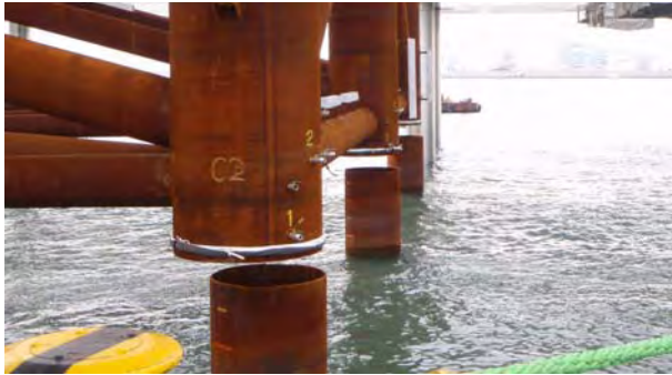
写真-6.6 杭挿入状況
