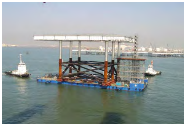
写真-5.3 ジャケット運搬台船係留（羽田工事海域）
