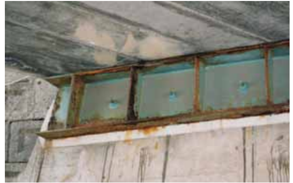
写真 - 3 既設の支承座の拡幅工
