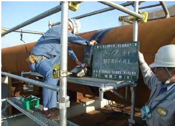
写真-3.7 溶接部検査
