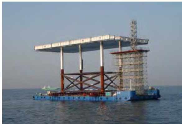
写真-5.2 ジャケット運搬
