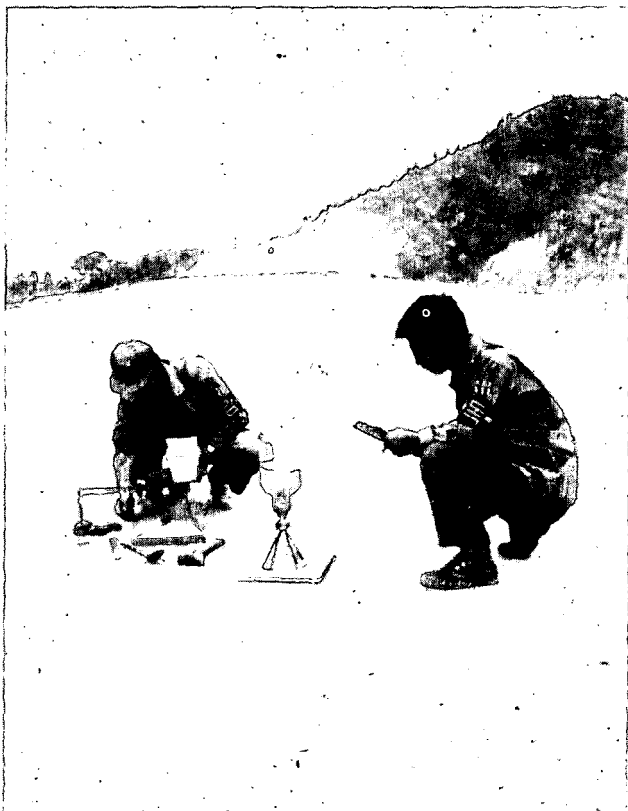
다짐도를 검사하는 현장 밀도시험
