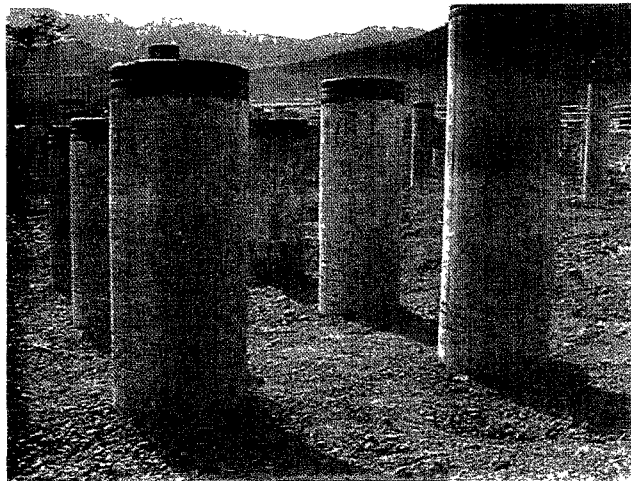
<사진은 보조컷팅선, 컷팅선, 버림콘크리트 상단면, 지반조성면의 4개의높이 표시>
