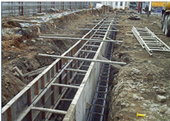
철근제작 및 거푸집 설치
