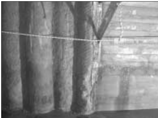
(그림 16) 콘크리트 타설 불량
