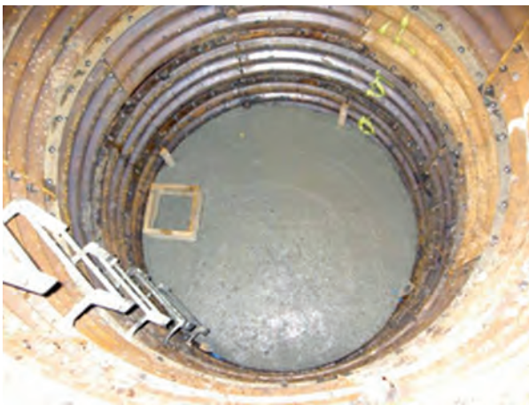
底盤コンクリート打設完了
