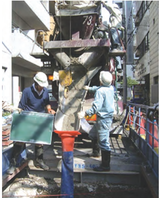
コンクリート打設
