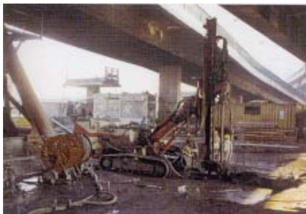
図-1.1.1 海外でのマイクロパイル施工事例 （既設構造物基礎の補強）
