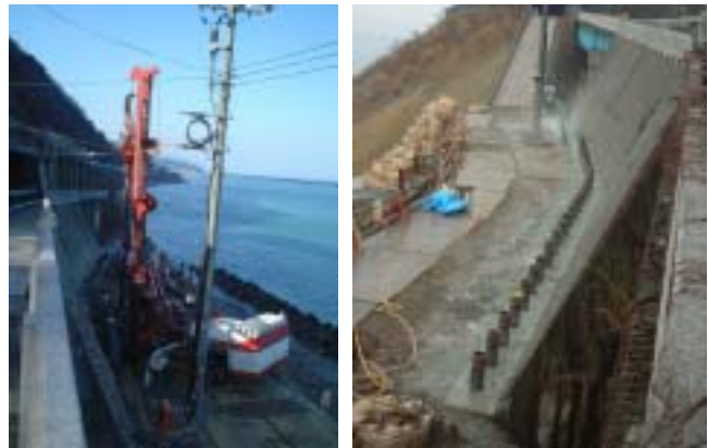
図-2.3.6 既設擁壁の補強状況図
