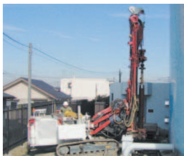
住宅地区における既設貯水槽の耐震補強施工状況
