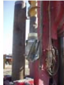
図-2.2.5 切削拡張ビットとオーガー併用の回転式削孔方式(土砂・粘性土・土丹)
