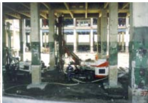
図-1.1.2 海外でのマイクロパイル施工事例 （既設構造物のアンダーピニング）
