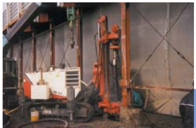
スノーシエッド基礎の補強（タイプ ）
