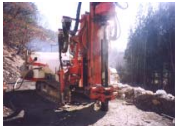
図-2.3.8 擁壁基礎の施工状況
