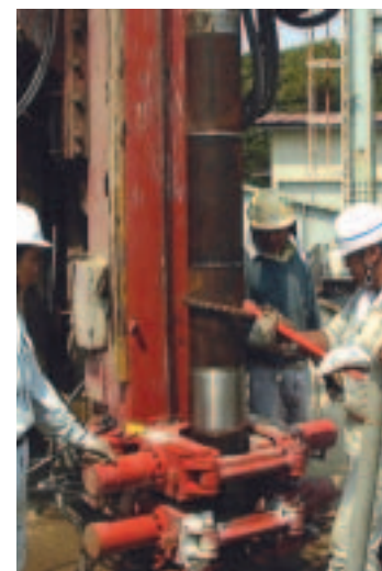
鋼管継手状況
