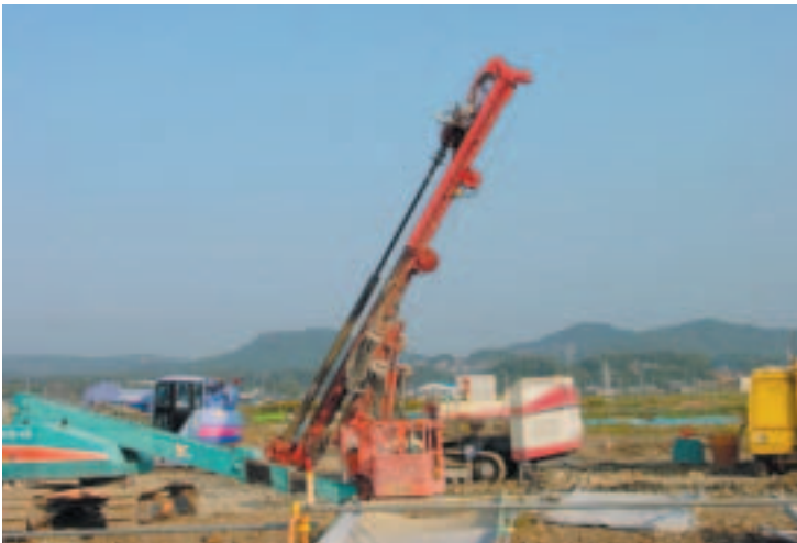
斜杭の削孔試験施工
