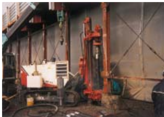
図-2.3.4 スノーシェッド既設基礎補強状況
