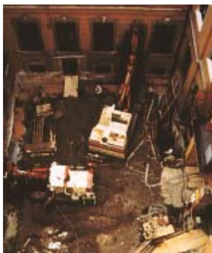
図-1.1.3 海外でのマイクロパイル施工事例 （狭隘地でのマイクロパイル打設）
