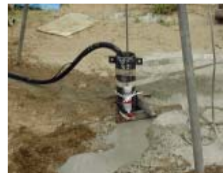
図-2.2.6 グラウトの加圧注入状況
