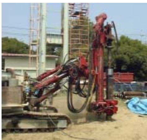
図-2.2.3 二重管削孔・鋼管打設状況
