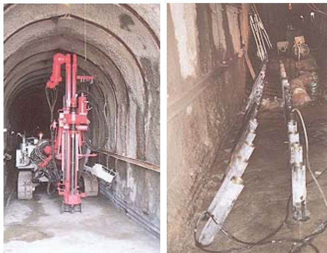
図-1.1.4 国内でのマイクロパイル施工事例 （山岳トンネルの脚部補強 1) ）
