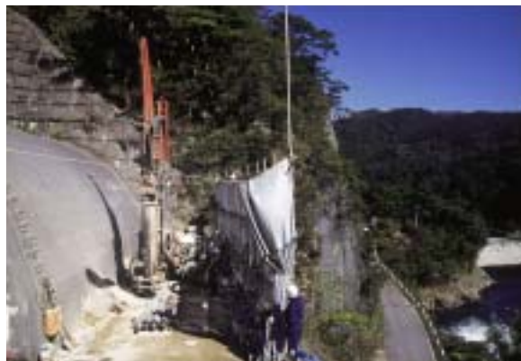
図-2.3.2 L型擁壁基礎杭施工状況
