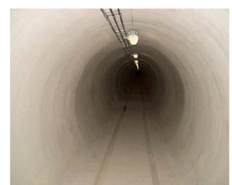
FIG-4. INSIDE OF DRAIN PIPE AFTER JACKING
