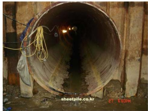
FIG-2. START SHIELD JACKING
