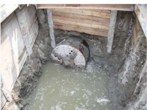
FIG-3. JACKING OPERATION COMPLETED
