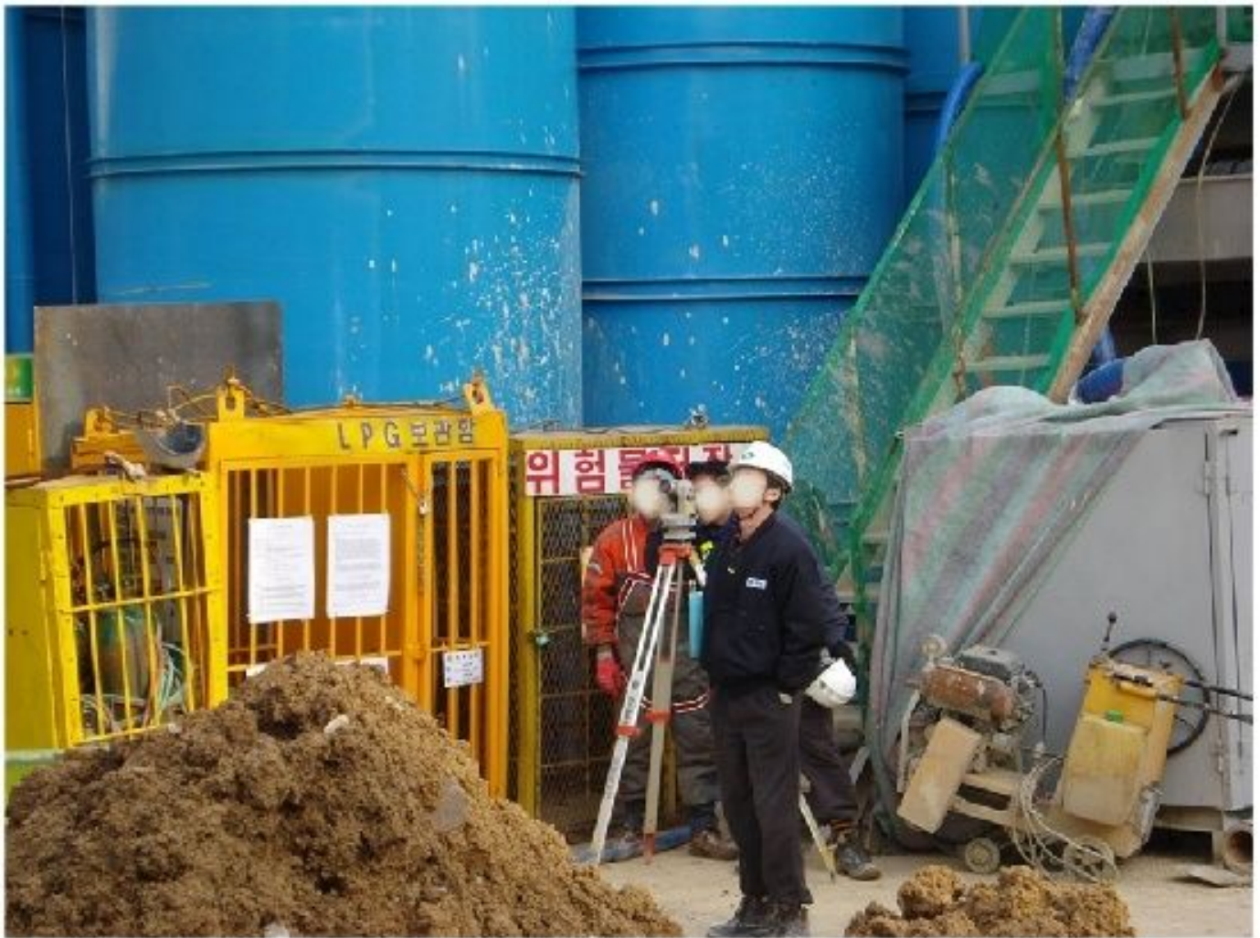
5. 굴착 시 트랜시트로 수직도 확인(X,Y 방향 2대 설치하여 수시로 확인)
