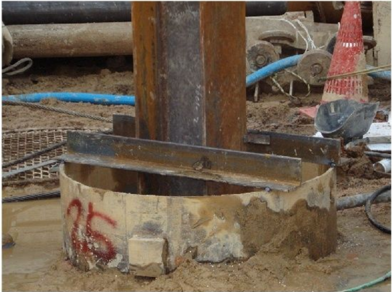
15. 철골 기둥 근입(가이드 앵글은 한쪽만 설치 후 철골이 소정의 깊이까지 근입되면 맞은편 가이드 앵글 설치 - 작업용이)
