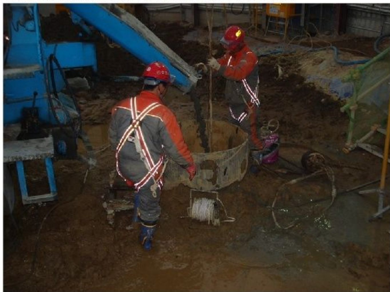
10. 철골 근입 레미콘 타설(트레미관 설치 및 타설 중 레미콘 타설 심도 확인)
