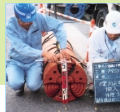
軟岩推進到達直後 土質: 泥岩(青灰色) 一軸圧縮強度: 20\sim30\text{N/mm}^2 管種: 200mm
